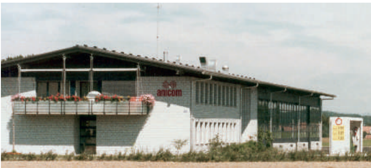
Neubau in Ohringen
